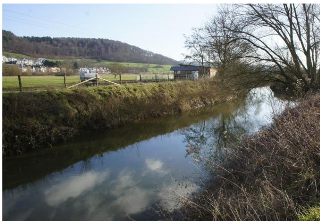
Foto gegen Fließrichtung
