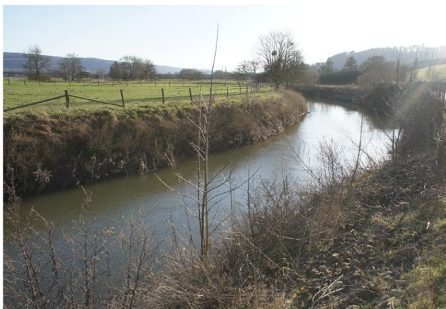
Foto gegen Fließrichtung
