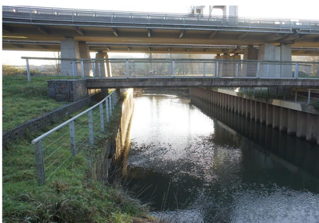
Foto gegen Fließrichtung
