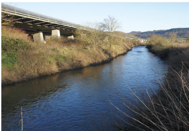
Foto gegen Fließrichtung
