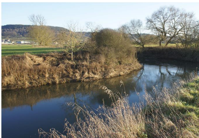
Foto gegen Fließrichtung
