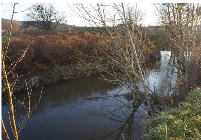
Foto gegen Fließrichtung
