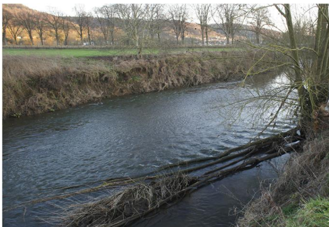
Foto gegen Fließrichtung
