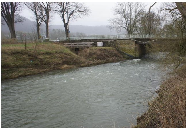
Foto gegen Fließrichtung
