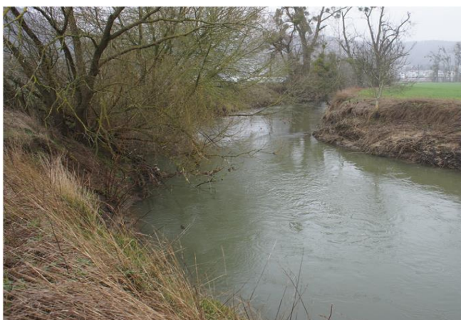
Foto gegen Fließrichtung
