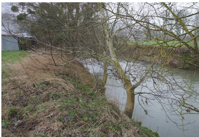
Foto gegen Fließrichtung
