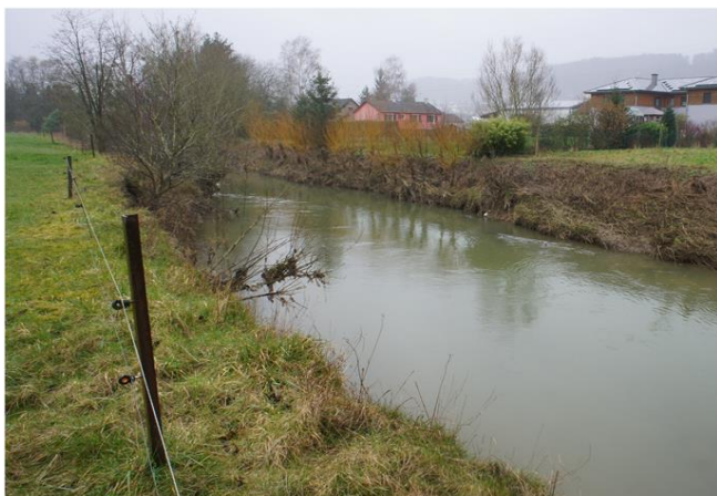
Foto gegen Fließrichtung
