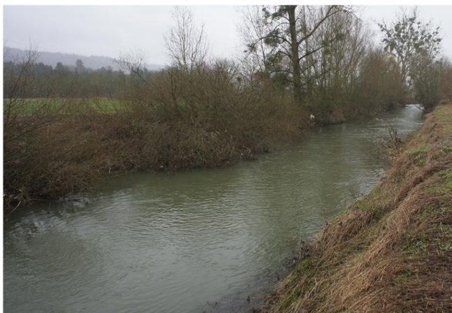
Foto gegen Fließrichtung
