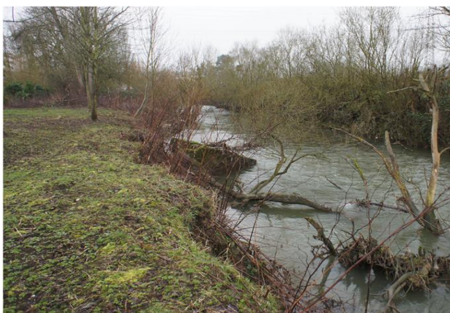
Foto gegen Fließrichtung
