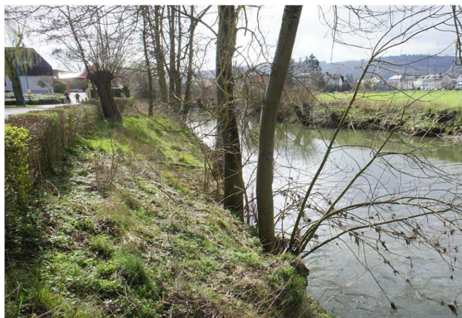
Foto gegen Fließrichtung
