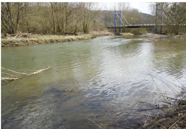
Foto gegen Fließrichtung
