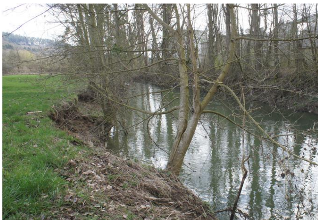
Foto gegen Fließrichtung
