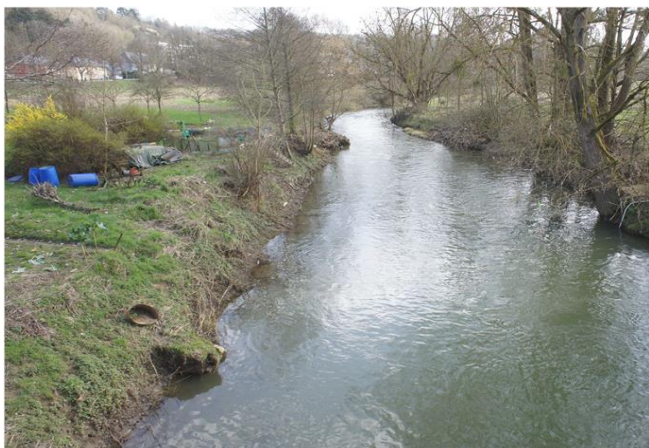
Foto gegen Fließrichtung
