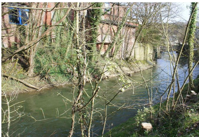
Foto gegen Fließrichtung
