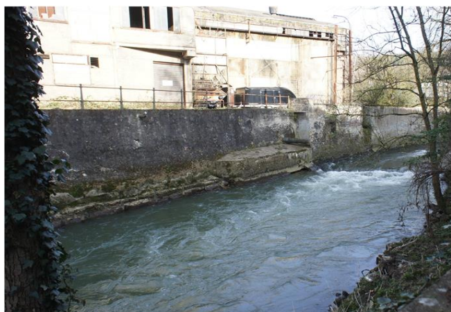
Foto gegen Fließrichtung
