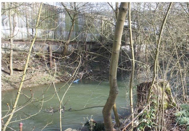
Foto gegen Fließrichtung
