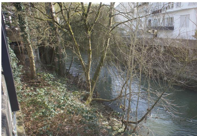
Foto gegen Fließrichtung
