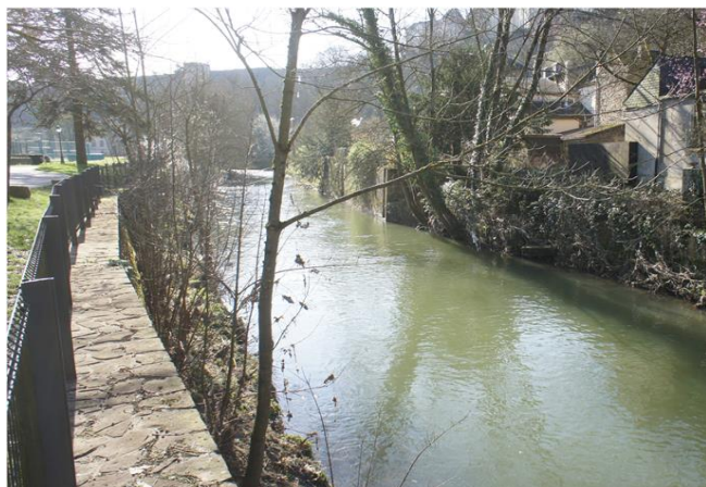
Foto gegen Fließrichtung
