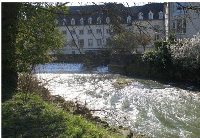
Foto gegen Fließrichtung
