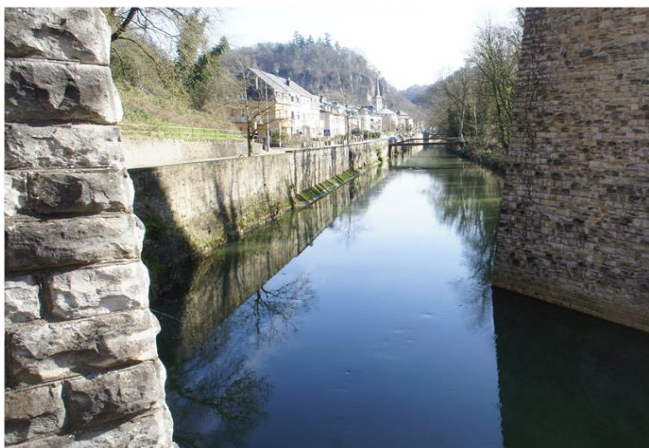
Foto gegen Fließrichtung
