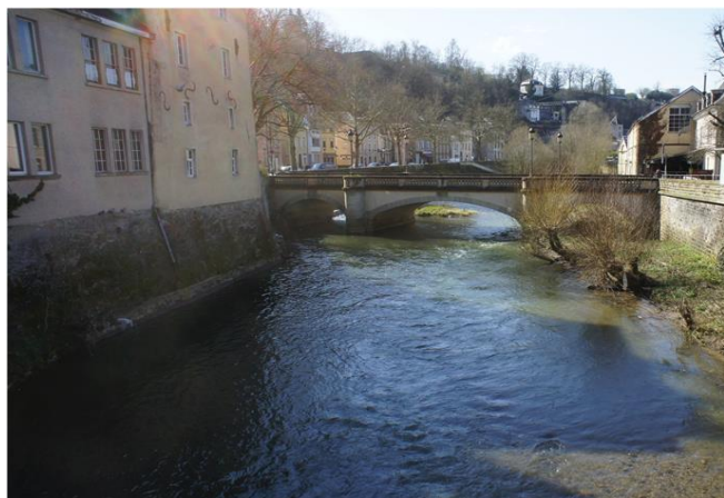
Foto gegen Fließrichtung
