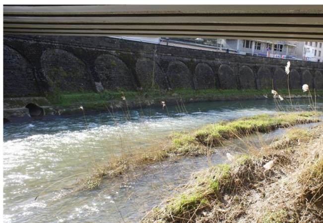
Foto gegen Fließrichtung
