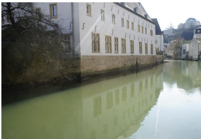
Foto gegen Fließrichtung
