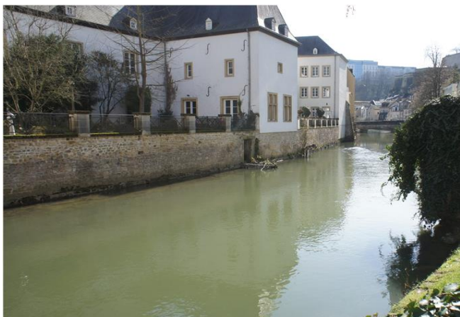
Foto gegen Fließrichtung
