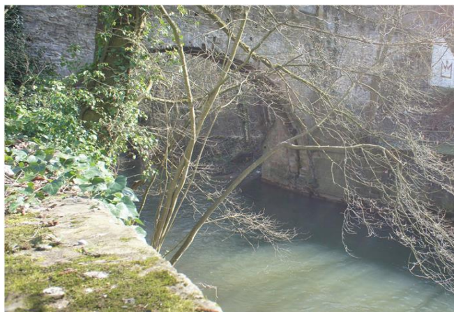
Foto gegen Fließrichtung
