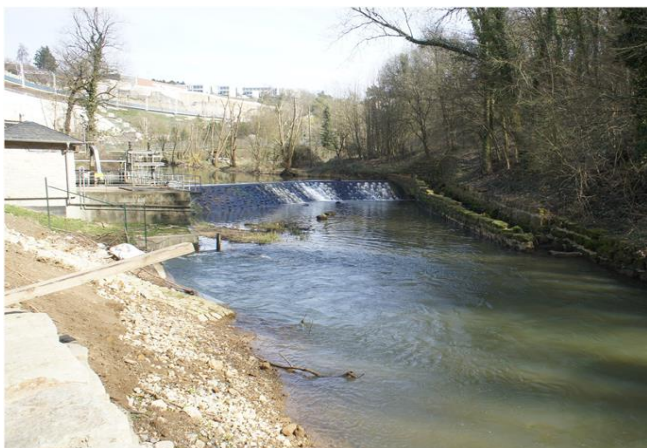
Foto gegen Fließrichtung
