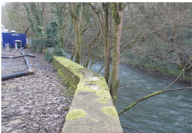
Foto gegen Fließrichtung
