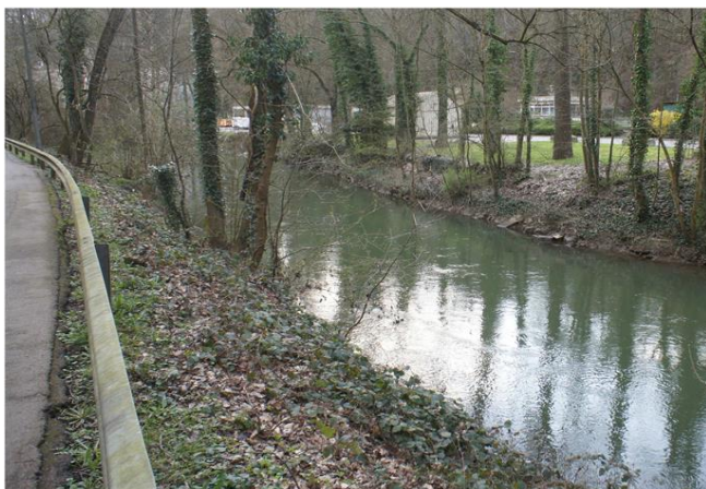
Foto gegen Fließrichtung
