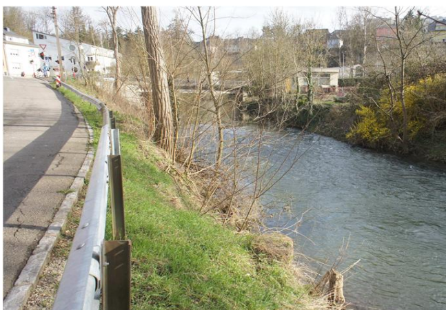
Foto gegen Fließrichtung
