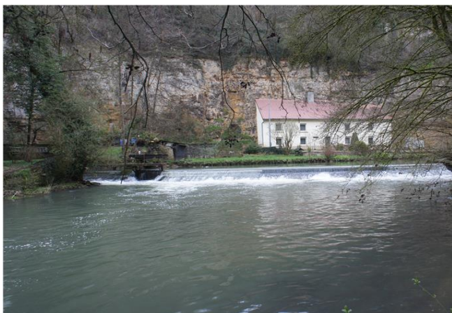
Foto gegen Fließrichtung
