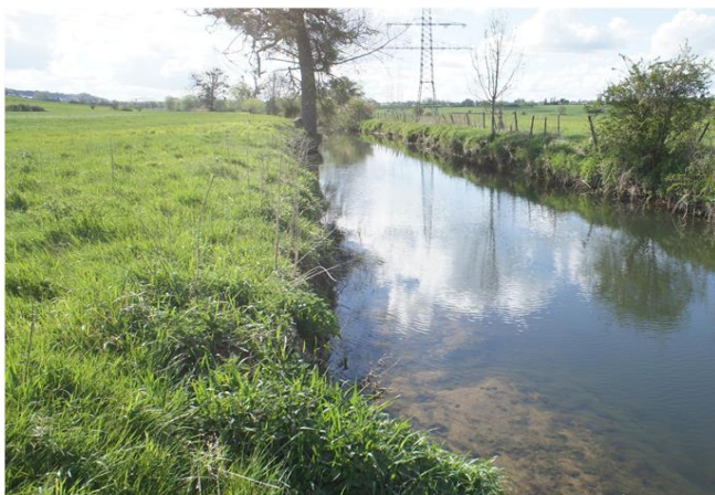
Foto gegen Fließrichtung
