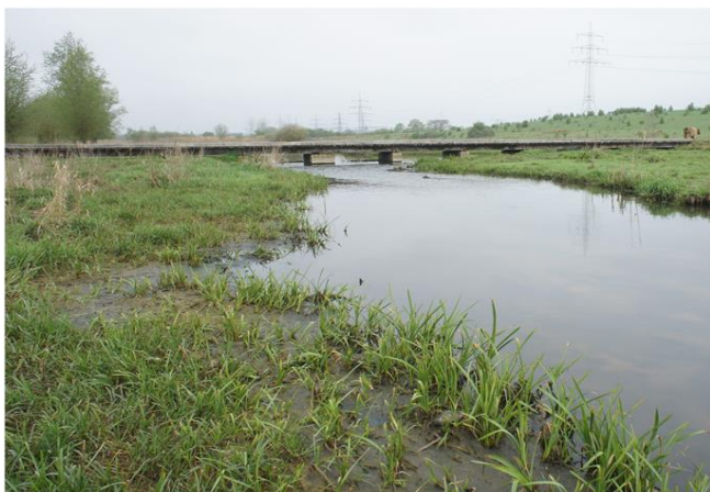
Foto gegen Fließrichtung
