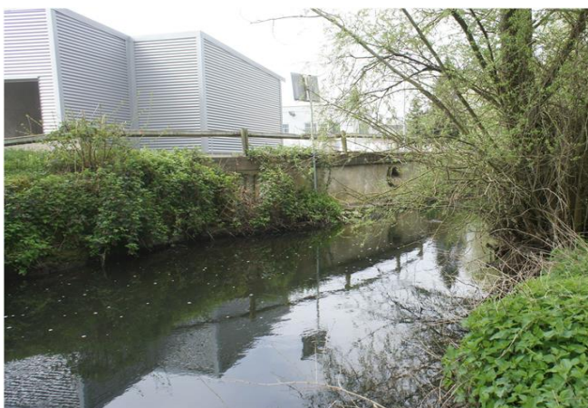
Foto gegen Fließrichtung
