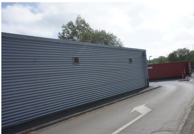
Foto gegen Fließrichtung
