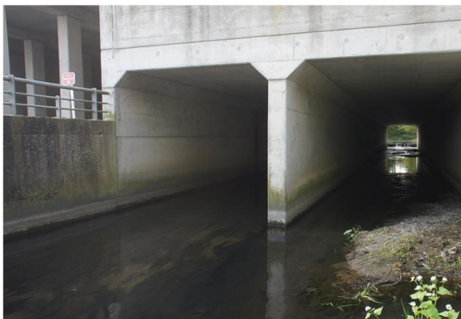
Foto gegen Fließrichtung
