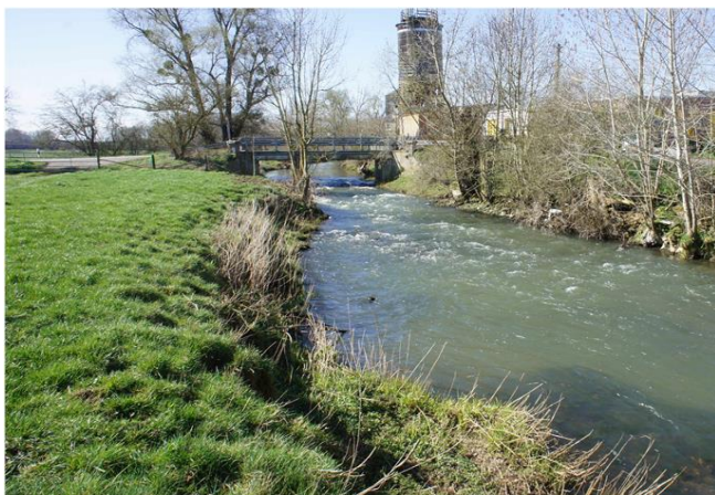
Foto gegen Fließrichtung
