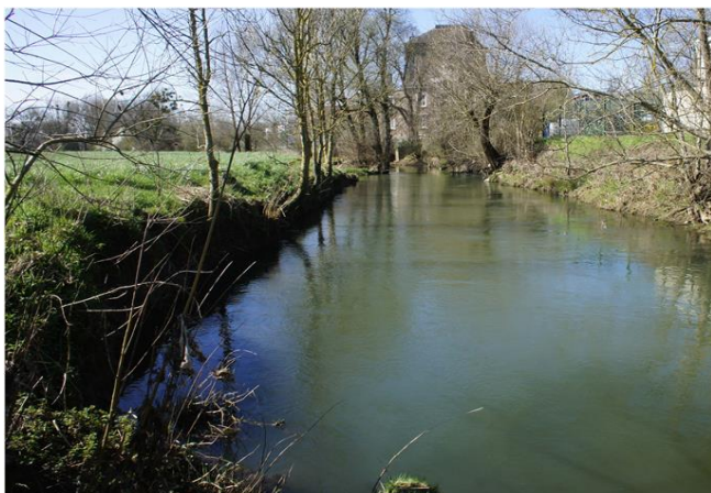
Foto gegen Fließrichtung
