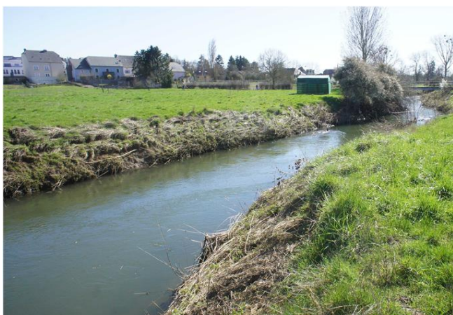
Foto gegen Fließrichtung
