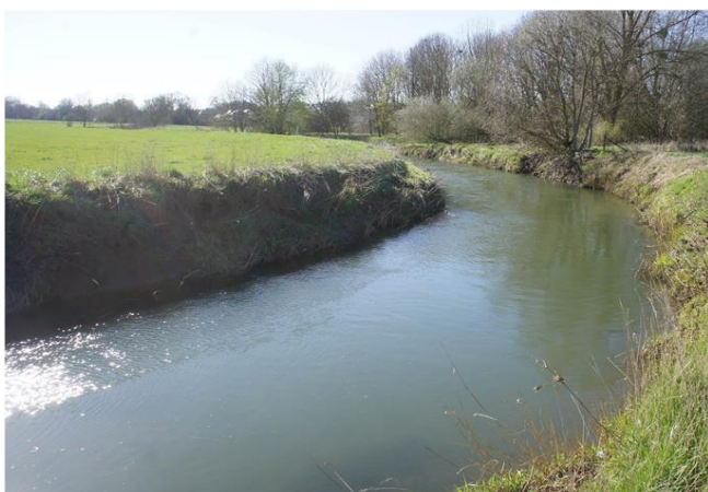
Foto gegen Fließrichtung
