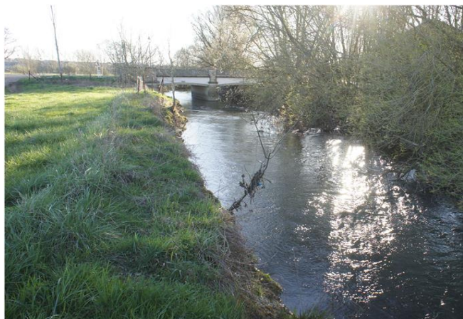
Foto gegen Fließrichtung
