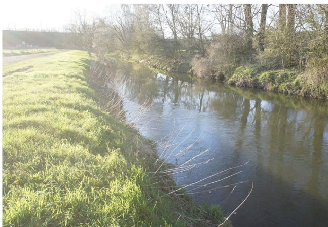
Foto gegen Fließrichtung
