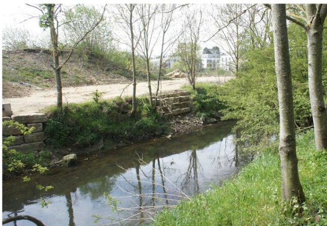
Foto gegen Fließrichtung
