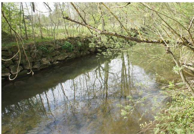
Foto gegen Fließrichtung
