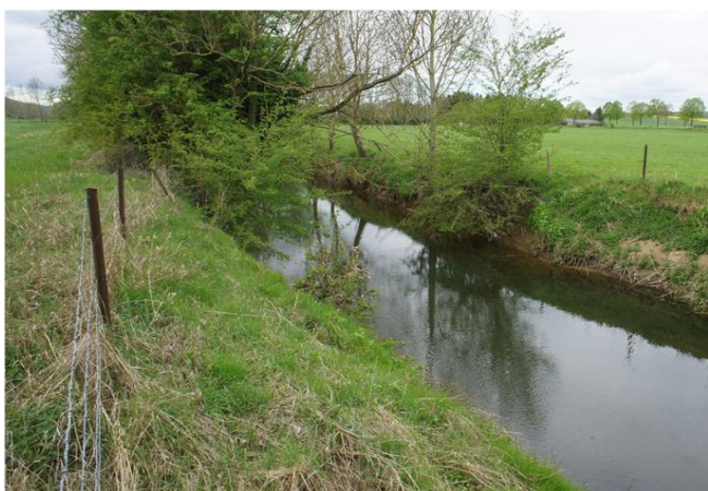
Foto gegen Fließrichtung
