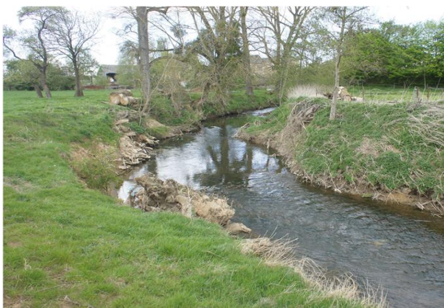
Foto gegen Fließrichtung
