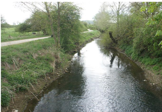
Foto gegen Fließrichtung
